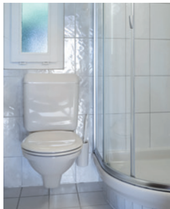
PRZED Sytuacja montażowa ze spłuczką natynkową
